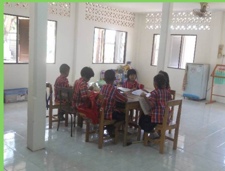
第3回2012年2月 水害被害校舎修復
